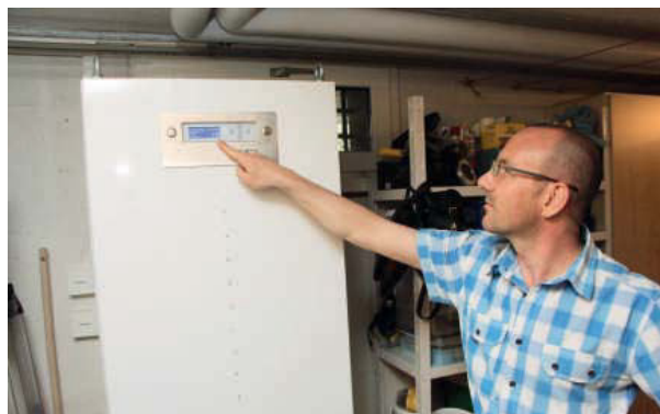
Thomas Merki: «Die Ladezustandsanzeige und die Verbrauchsanzeige ist über den im Engion-Family-Speicher (Höhe: 1,85 m) integrierten Display leicht ersichtlich.»
